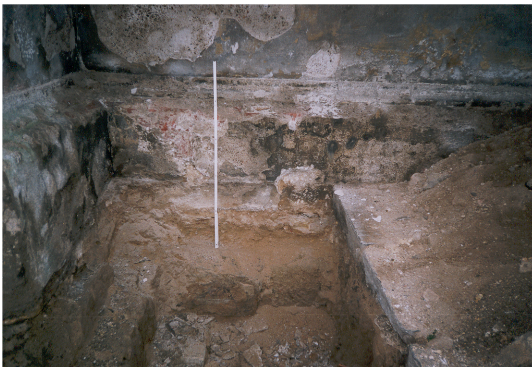
Obr. 6 Napojení jižní obvodové zdi a opěráku.
