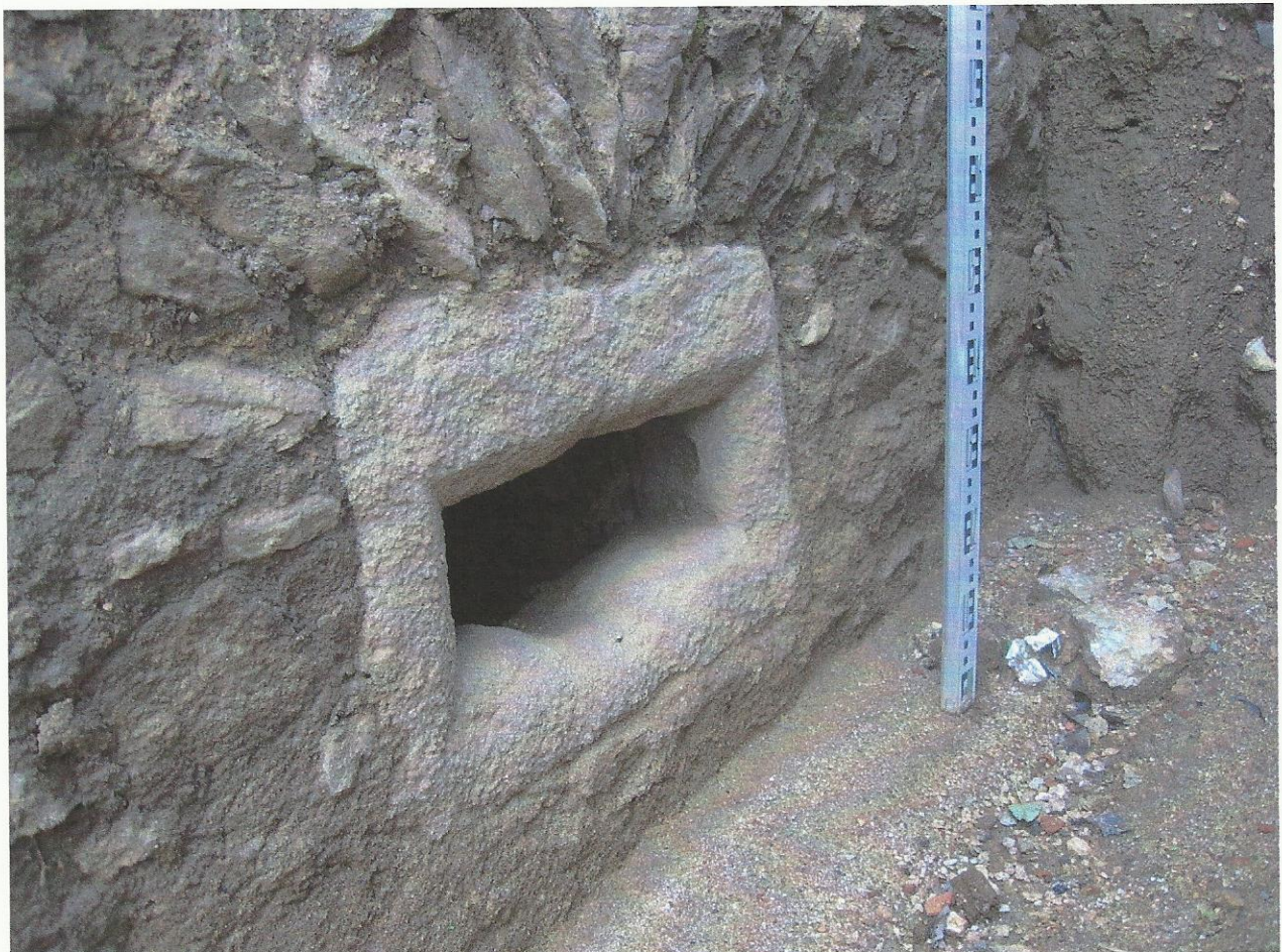
Řesanice, sklep černé kuchyně, vnější pohled na okno ve východní zdi
