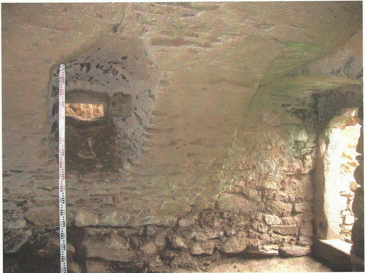
Řesanice, sklep černé kuchyně, pohled na východ
