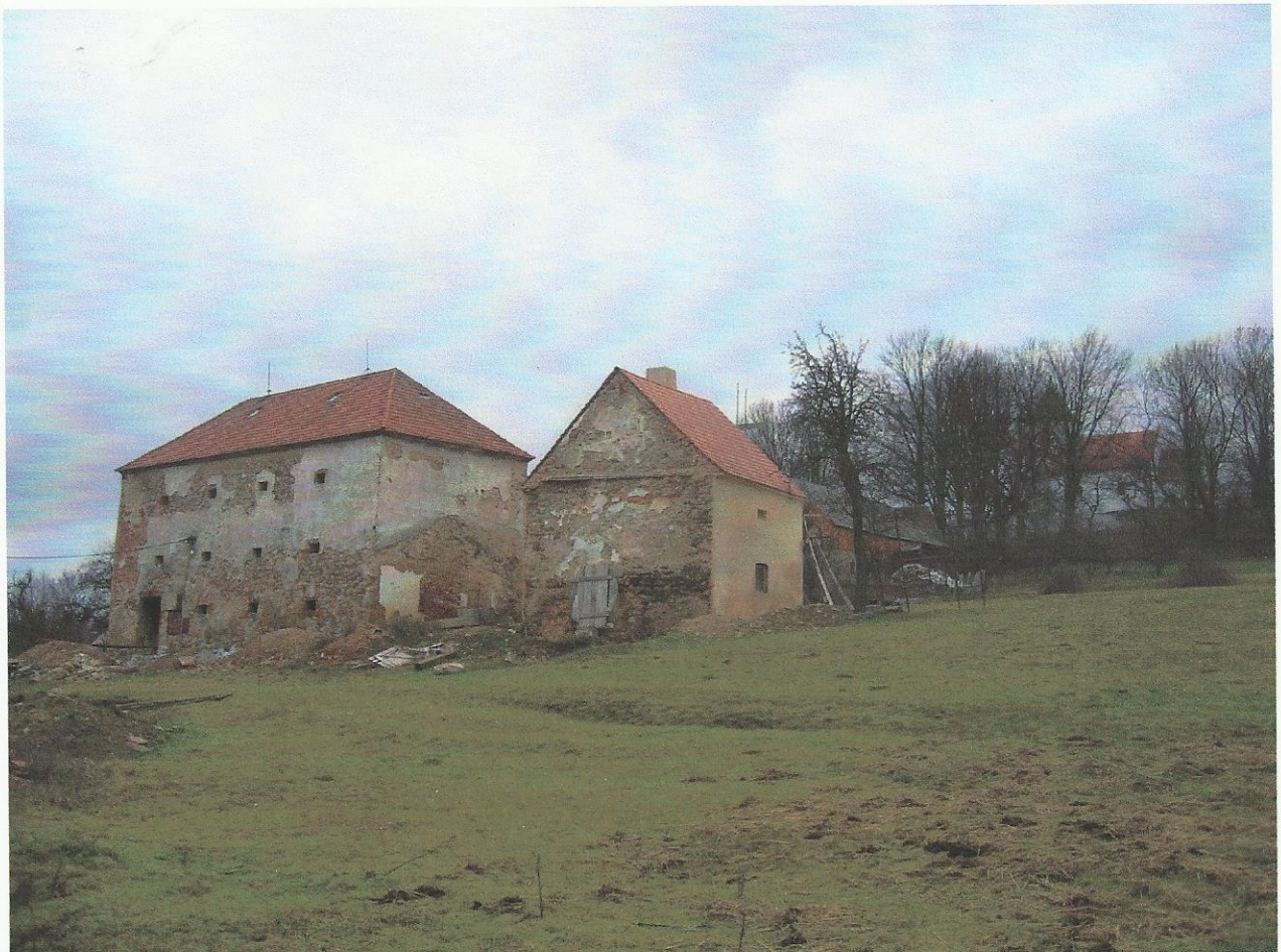
objekty tvrže v Řesanících
